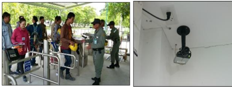
Figure 5.2B การผ่านเข้า-ออกโดยใช้ลายนิ้วมือ และการติดตั้งระบบกล้องวงจรปิด เพื่อป้องกันบุคคลภายนอกเข้าเขตหวงห้าม
